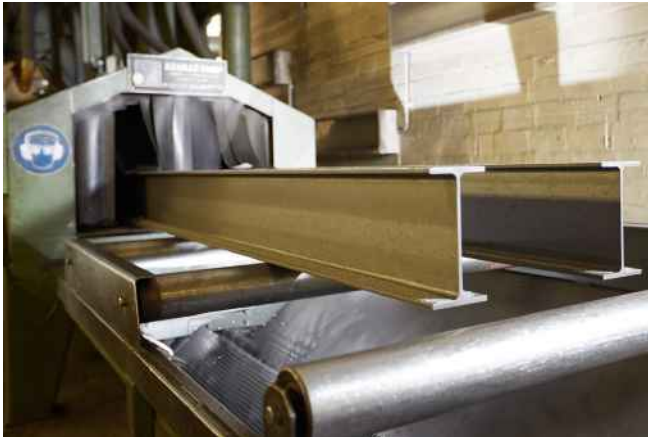
Schritt 1: Alle Stahlbauteile werden vor der Verarbeitung gestrahlt
